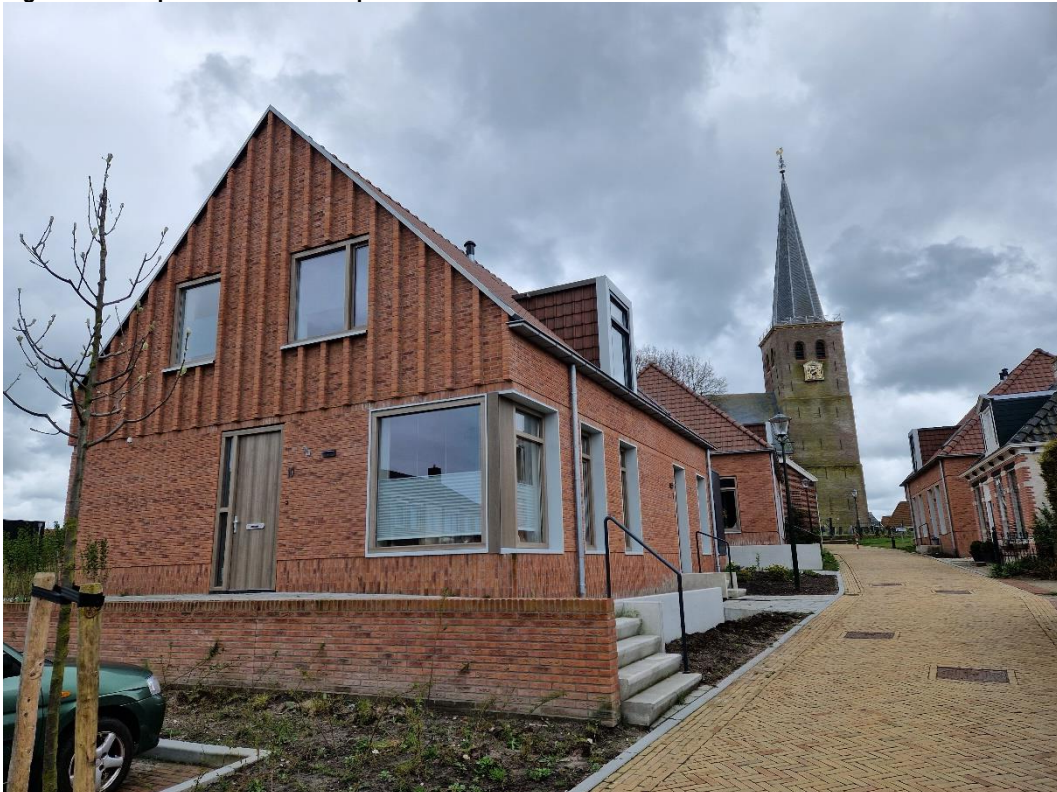
Figuur 1.1 Sloop en nieuwbouw terp Hallum
